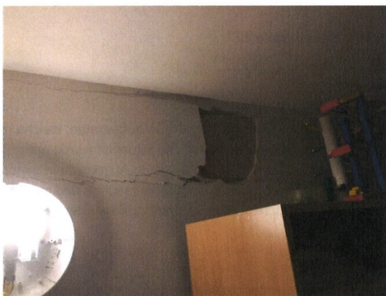
Wandrisse unter einer Galerie mit großflächiger Putzablösung.
