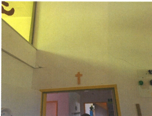
Diagonalrisse in einer Querscheibe.
