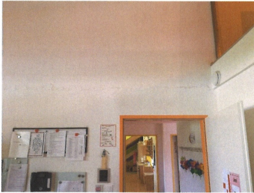
Horizontaler Riss in einer Querscheibe.
