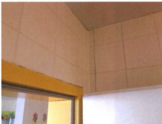
Gerissene und geöffnete Fugen der Verfliesung unter einer Galerie.
