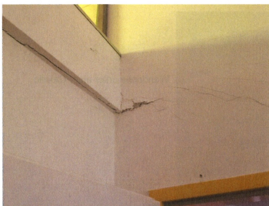
Risse an einer Querwand.
